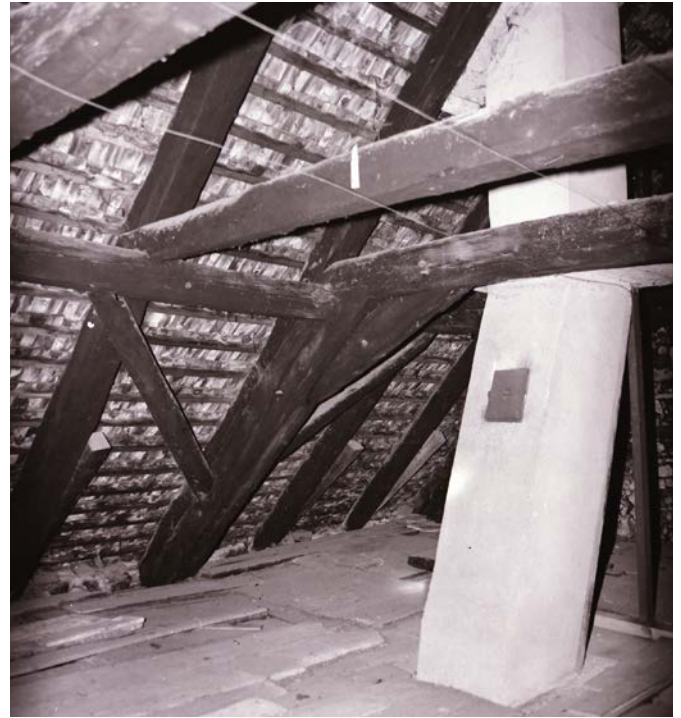
16 Der Dachraum war durch die liegende Stuhlkonstruktion stützenfrei und offen. Nur der Kamin ragte in der Mitte des Dachraums auf. Foto, um 1980 (FLM Gschwend 2402).
