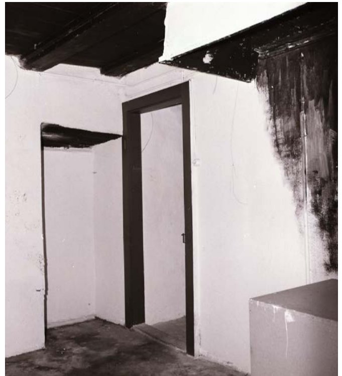
20 In der Küche im ersten Obergeschoss hatte sich der Rauchfang erhalten. Neben dem Durchgang zur Stube ist eine Wandnische zu sehen, die als ursprünglicher Eingang gedeutet wurde. Foto, um 1980 (FLM Gschwend 2394).
