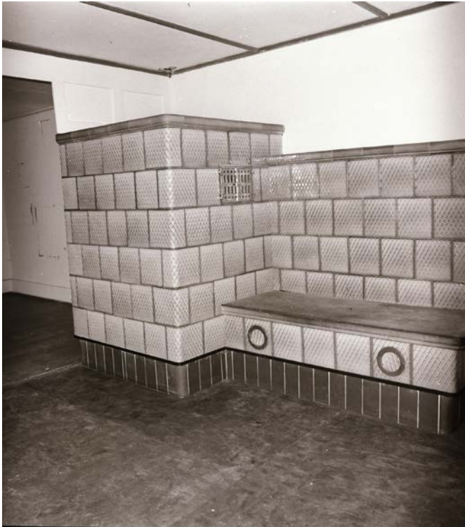
19 Im ersten Obergeschoss befand sich ein grosser Kachelofen aus dem 20. Jahrhundert, der an die schmale, hölzerne Trennwand zwischen Stube und Nebenstube anschloss. Foto, um 1980 (FLM Gschwend 2391).
