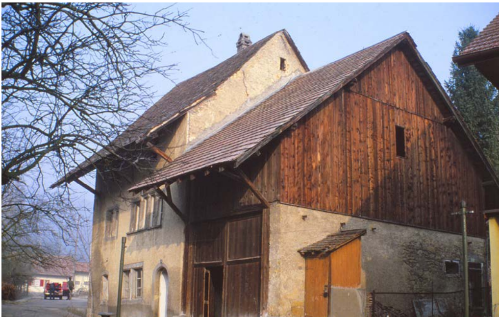
6 Der Scheunen- und Stallanbau hatte ein grosses Scheunentor im Süden und einen kleinen Stalleingang im Osten. Der Abort befand sich an der Ostwand der Scheune. Dia, um 1980 (FLM BalFot 12441).
