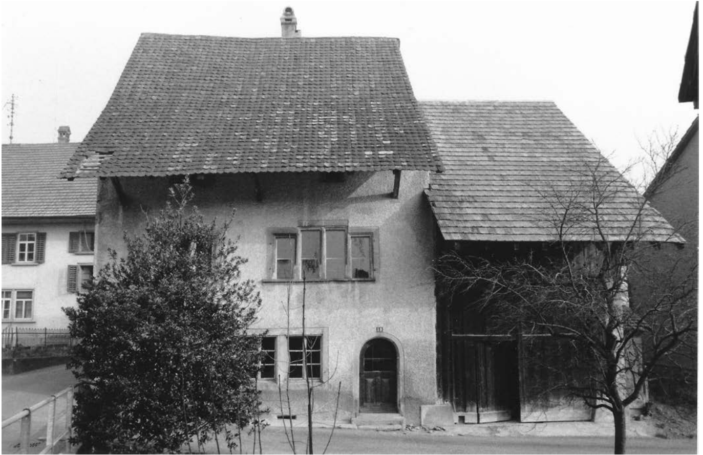
21 Die nach Süden ausgerichtete Schauffassade des Wohnhauses aus Villnachern AG wies Fensteröffnungen aus verschiedenen Jahrhunderten auf. Deutlich ließ sich an den unregelmässig angeordneten Fenstern die dahinter befindliche Raumnutzung ablesen: Hinter dem vierteiligen Staffelfenster befand sich die Stube (FLM digKat).
