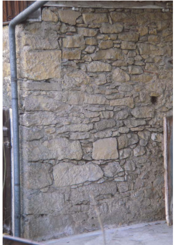
8 Die Nordostecke der an das Wohnhaus angebauten Stallscheune war aus Bruchsteinen mit grossen Eckquadern gemauert. Dia, um 1980 (FLM BalFot 12452).
