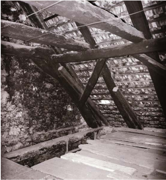
15 Vor den Giebelseiten waren im Dachraum zwei Hauptgebände angeordnet. Foto, um 1980 (FLM Gschwend 2401).
