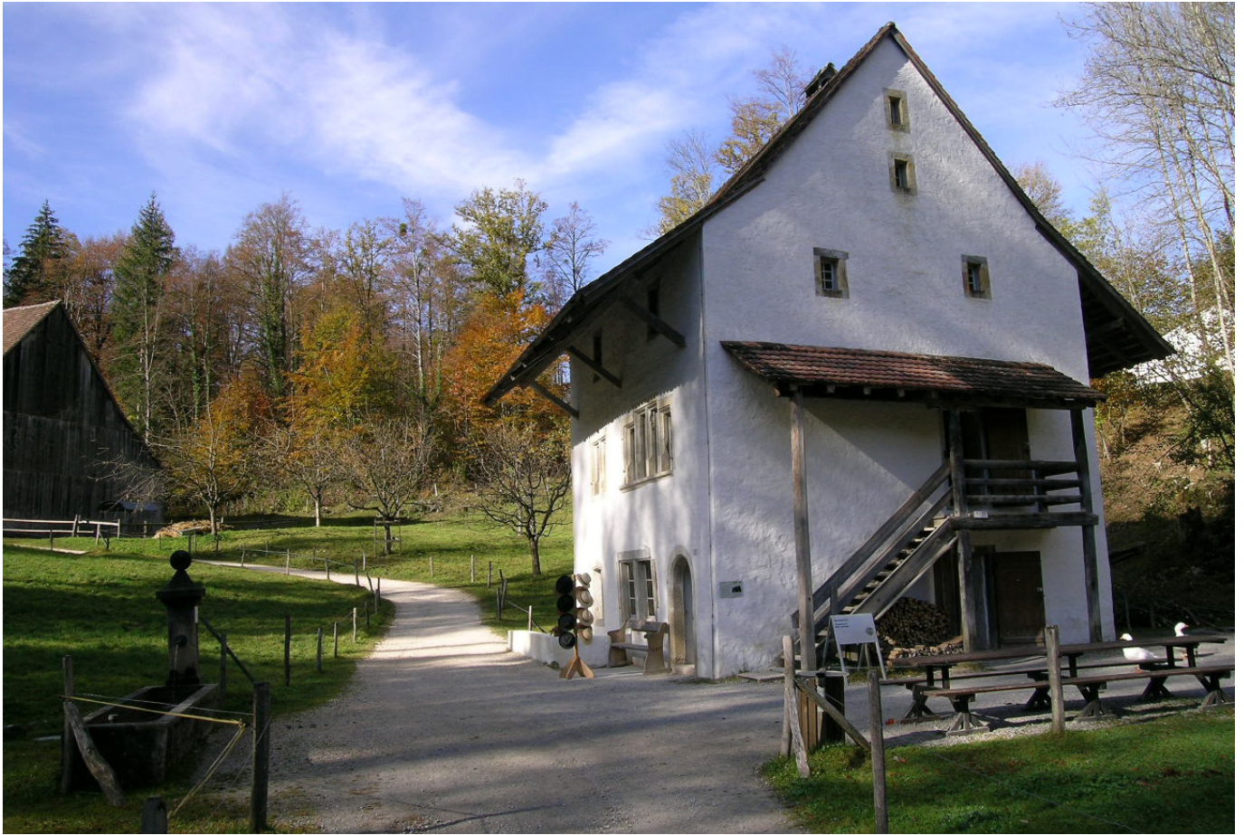
24 Im Museum wurde der Zugang zum ersten Obergeschoss an die Ostfassade verlegt. Die nicht bauzeitliche, angebaute Stallscheune wurde nicht übernommen. Der Zugang in das zweite Obergeschoss wurde in den Innenraum verlagert. Foto, 2009 (FLM digKat).
