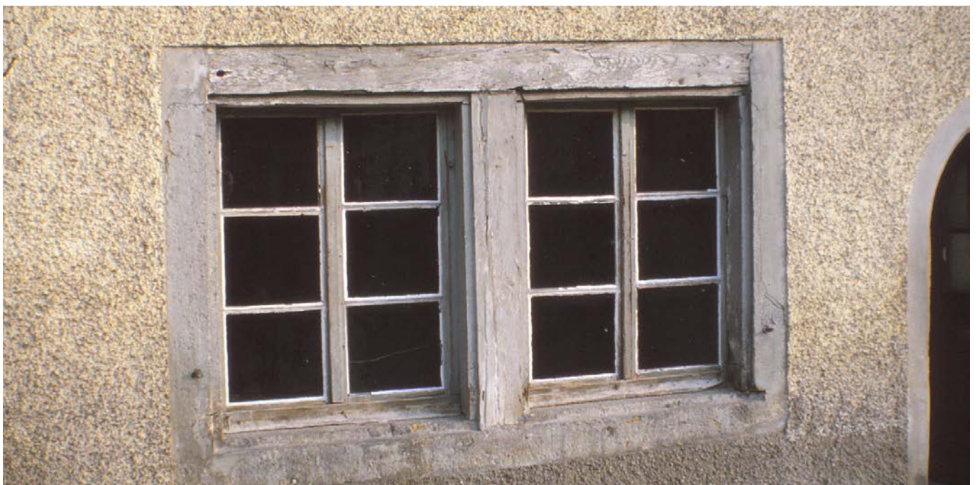
10 Holz und wiederverwendete Steinbauteile wurden für das Fenstergewände des Doppelfensters im Erdgeschoss verwendet. Dia, um 1980 (FLM BalFot 12445).
