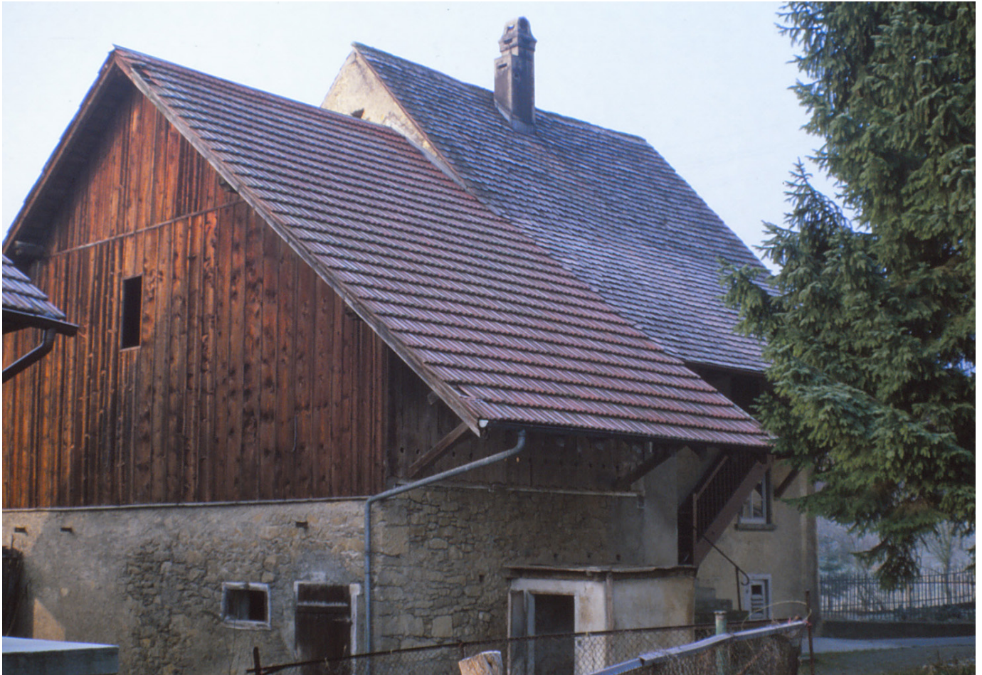
9 Auf der Rückseite der Stallscheune befand sich ein kleines Hühnerhaus. Hinter der vorkragenden Scheune sind der Treppenaufgang zur Wohnung im ersten Obergeschoss und die Nordfassade des Wohnhauses zu sehen. Dia, um 1980 (FLM BalFot 12451).
